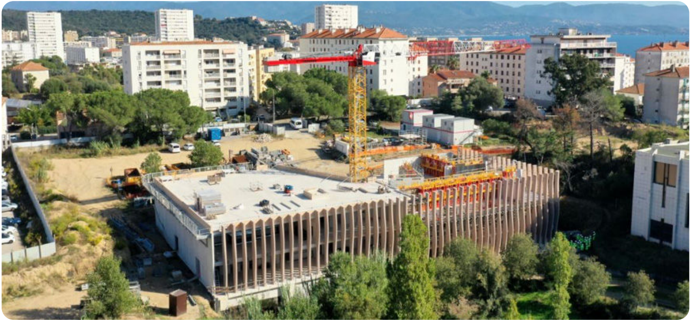
Crédit - Roch Leandri BTP : Avancement du Gros Œuvre.
