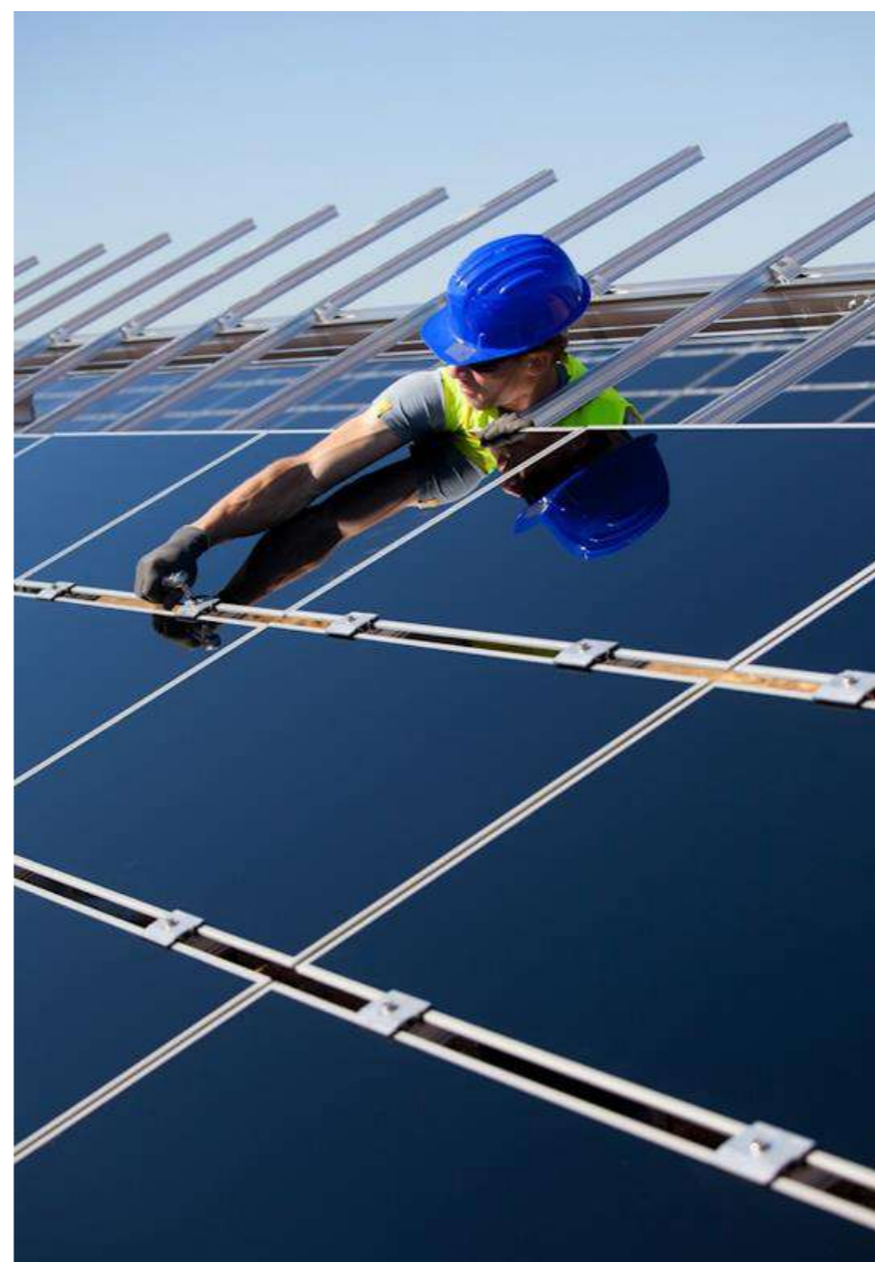
Remplacement de module (crédit photo EDF Renewables)
