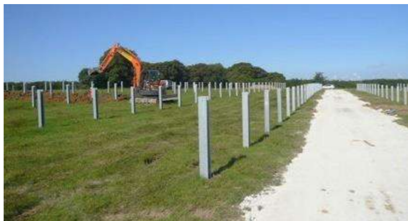
Travaux de montage des supports des modules (crédit photo :Ectare)
