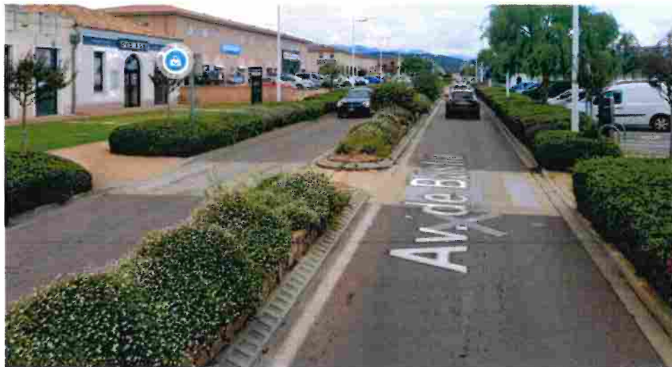
Végétalisation de terre-pleins centraux (TPC)
