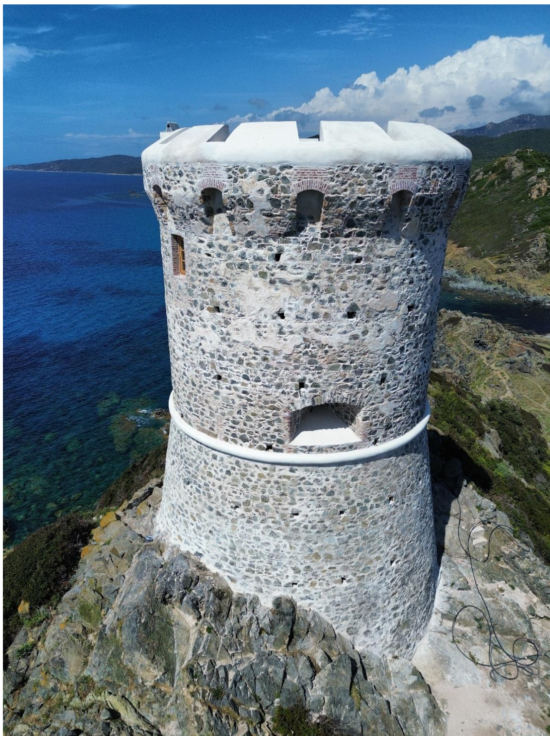
Façade Ouest avec l'ouverture de la cannière au R+1
