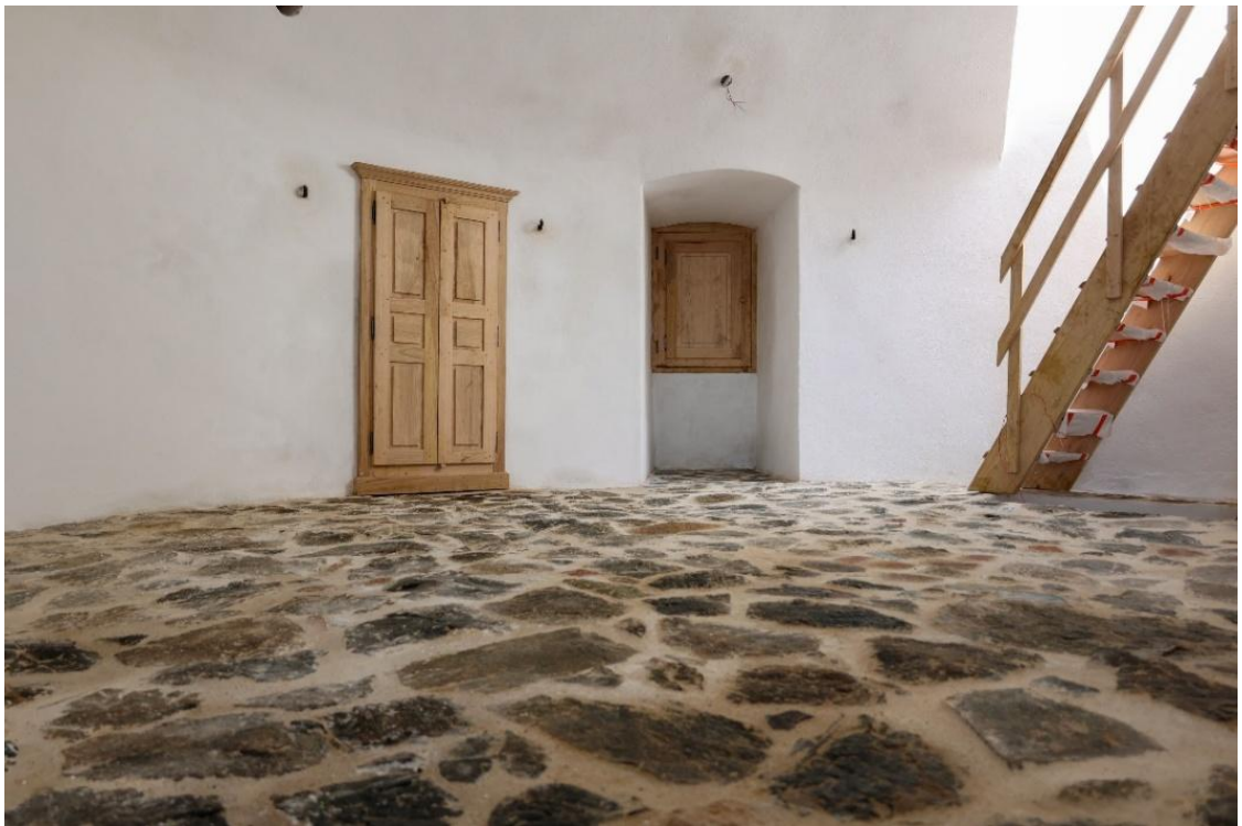
Intérieur R+2 : dallage en diorite, escalier et menuiseries en châtaignier
