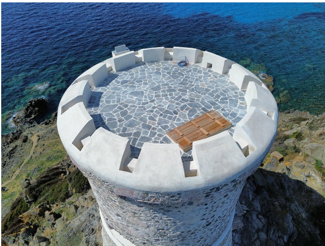
Détails de la reprise des mâchicoulis en couronnement
